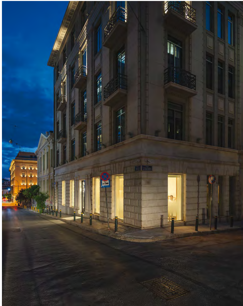
Η ΟΡΓΑΝΩΣΗ ΤΗΣ ΝΕΟΚΛΑΣΙΚΗΣ ΟΨΗΣ ΑΚΟΛΟΥΘΕΙ ΤΗΝ ΤΡΙΜΕΡΗ ΔΙΑΡΘΡΩΣΗ ΣΕ ΒΑΣΗ, ΚΟΡΜΟ ΚΑΙ ΣΤΕΨΗ.
